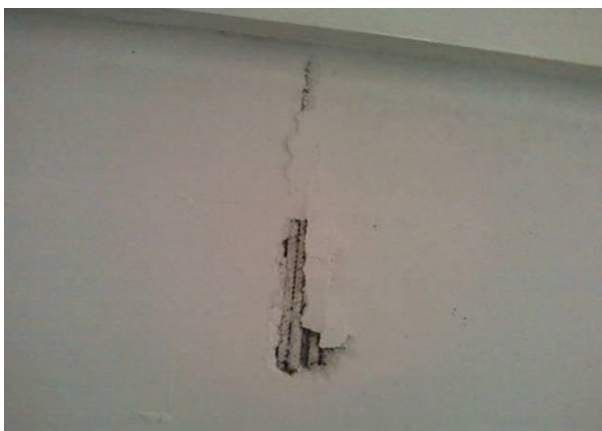
Foto 15 – Disgregação do concreto com armadura exposta e corroída na laje da Viga calha do eixo 13, entre eixos A'/B'.
