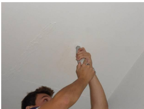
Foto 81 – Realização de ensaio de esclerometria na laje do Hall Nobre 3 (Ponto 6).
