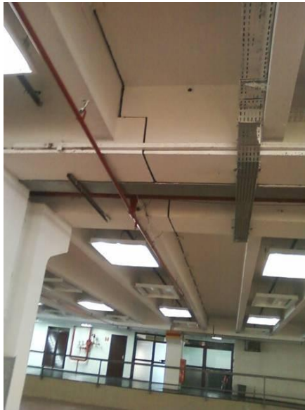
Foto 33 – Vista da junta de dilatação transversal localizada entre os eixos 1/2, 2/3 e H/I.
