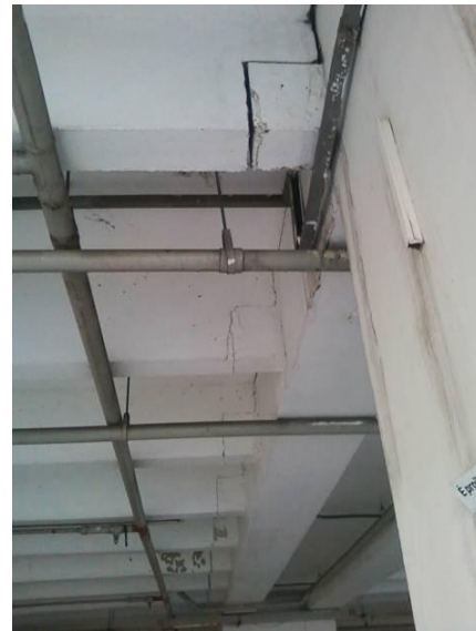
Foto 34 – Vista da junta de dilatação longitudinal localizada entre os eixos 3/4 e A/B, junto à Viga longitudinal do eixo 3.
