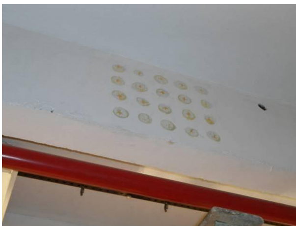
Foto 79 – Detalhe do ponto nº 5 do ensaio de ultrassom na viga diagonal.
