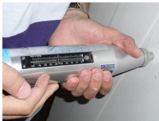
Foto 82 – Detalhe do ensaio de esclerometria no Pilar P2G (Ponto 3).
